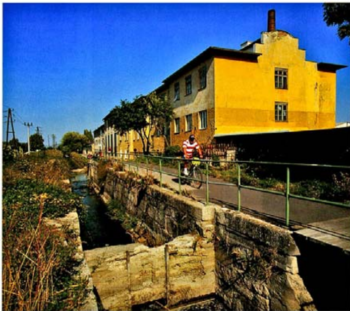
Von Laxenburg bis Kottlingbrunn wird der Kanal heute von einem sehr beliebten Radweg begleitet. Hier bei Tribuswinkel sind die originalen Schleusenklammern erhalten.
