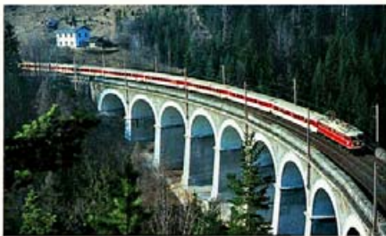
Das berühmte Kalte Rinne-Viadukt, wie es sich heute darbietet.
