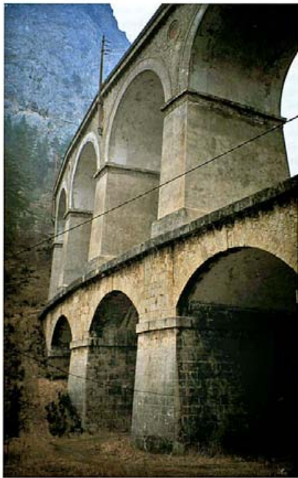
Detail des 46 m hohen Kalte Rinne Viadukts.
